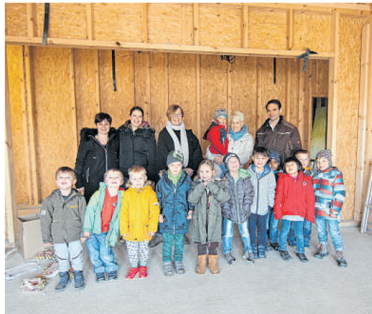
Die Kinder aus der AWO-Kita Fettweide schauen sich an, ob am Neubau am Büddenberg ordentlich gearbeitet wird. Im April soll dort alles fertig sein. FOTO: HARTMUT BREYER
