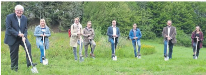
Erfreuliches Ereignis: Am Freitag erfolgte der Spatenstich für die Tiefbauarbeiten zur Errichtung der neue Kita Löh.
