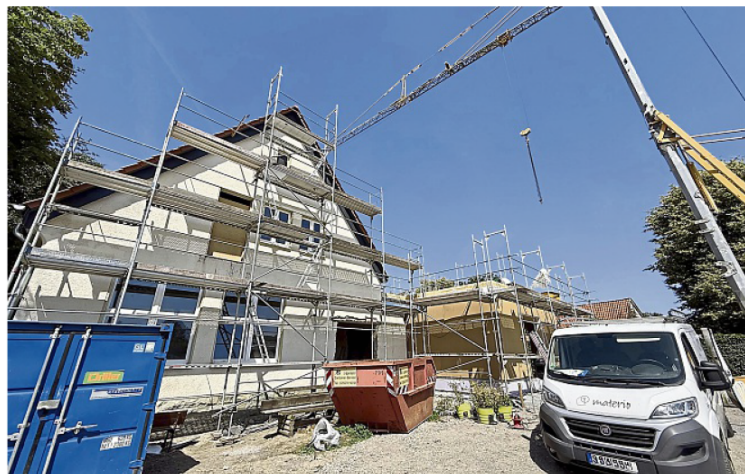
Der neue Anbau , der mit dem Bestandsgebäude der Kita in Dinker verbunden werden soll, wächst in die Höhe. SARAH HANKE
